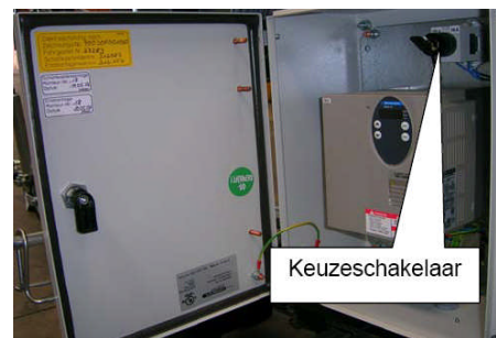
Abb. 131: Schakelkast
